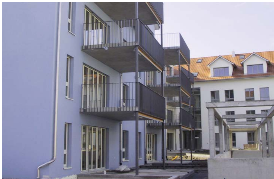
Wohnhäuser Sägestrasse 1 (blaue Fassade) und Sägestrasse 3 (weisse Fassade). ▶
