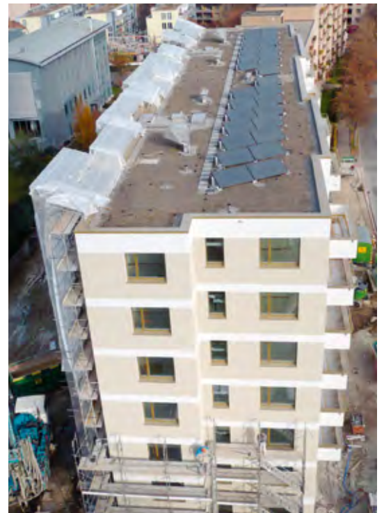
Dachansicht mit Solar Elementen Gebäude Sackzelg
